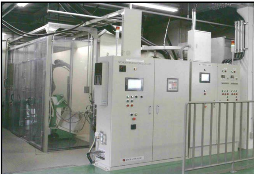
▲粉体塗装ブースと塗装機器制御盤・タッチパネル・乾燥炉制御盤
