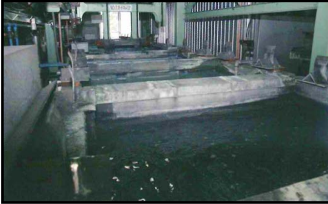
▲アルミ 3 価クロム皮膜処理ラインの処理槽
