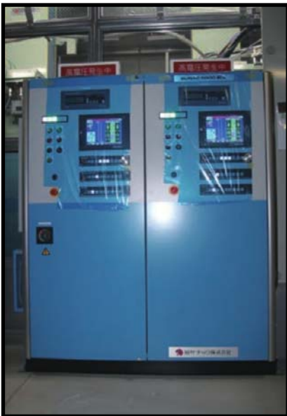
▲塗装制御盤 (SUNAC5000EX)
