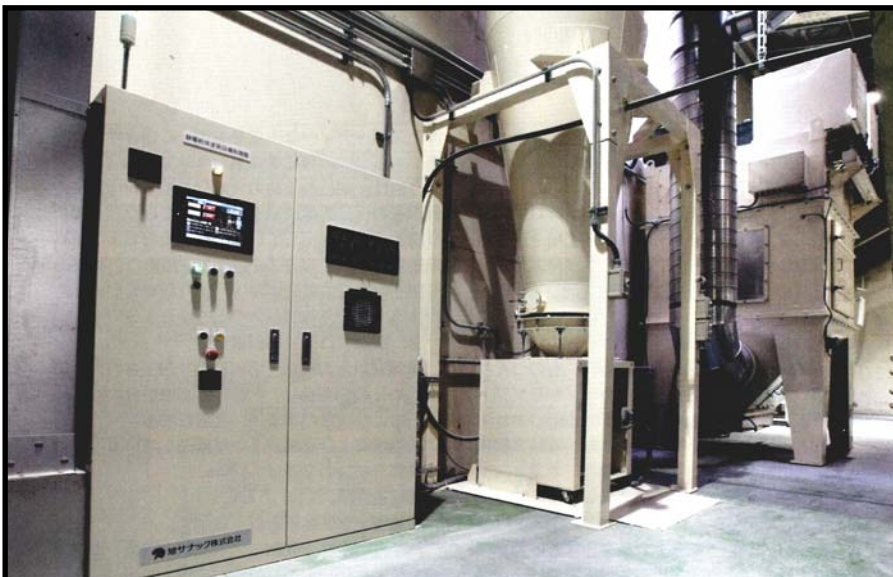
▲塗装ブースの外回り(左手前から、粉体塗装制御盤, サイクロン, 集塵(しゅうじん)機)
