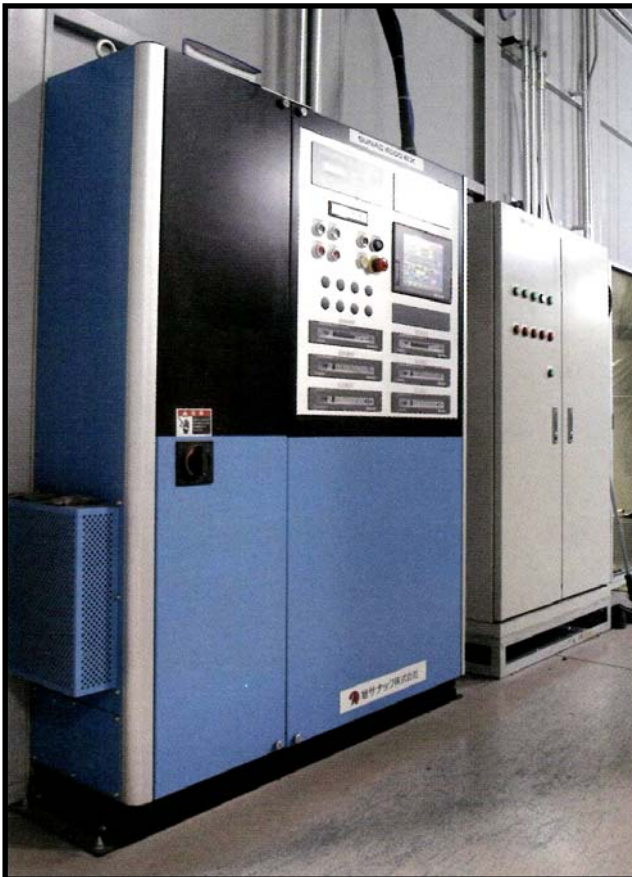
▲塗装制御盤 (SUNAC4000EX)
