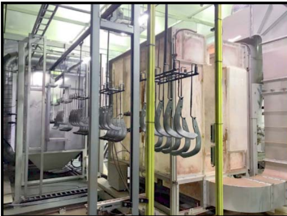
▲左奥の固定色専用粉体塗装ブースへ進行するワーク/右手前は色替え用の粉体塗装ブースで前後に移動可能
