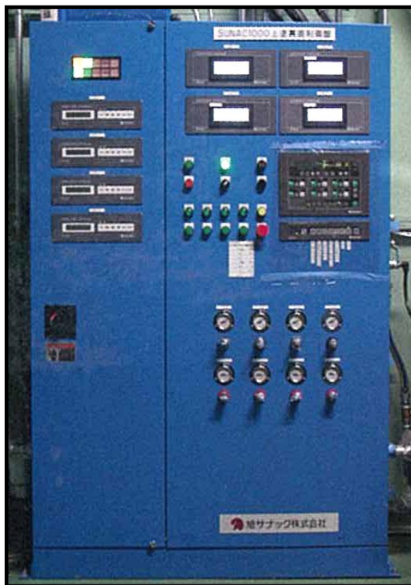
▲中塗り塗装制御室
