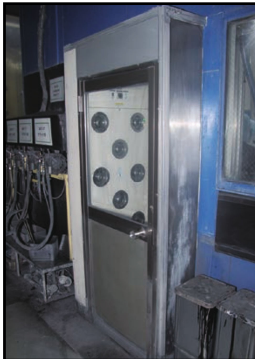
▲ 塗装エリア入口のエアシャワー
