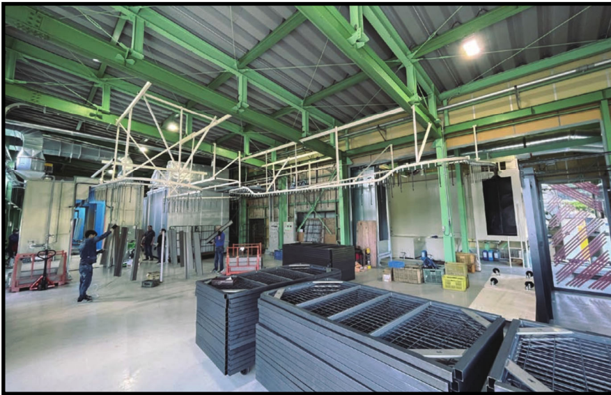
▲工場内 前処理/塗装ラインの全容
