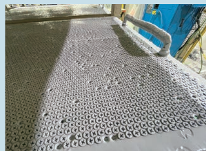
ネジ頭の塗装完了
