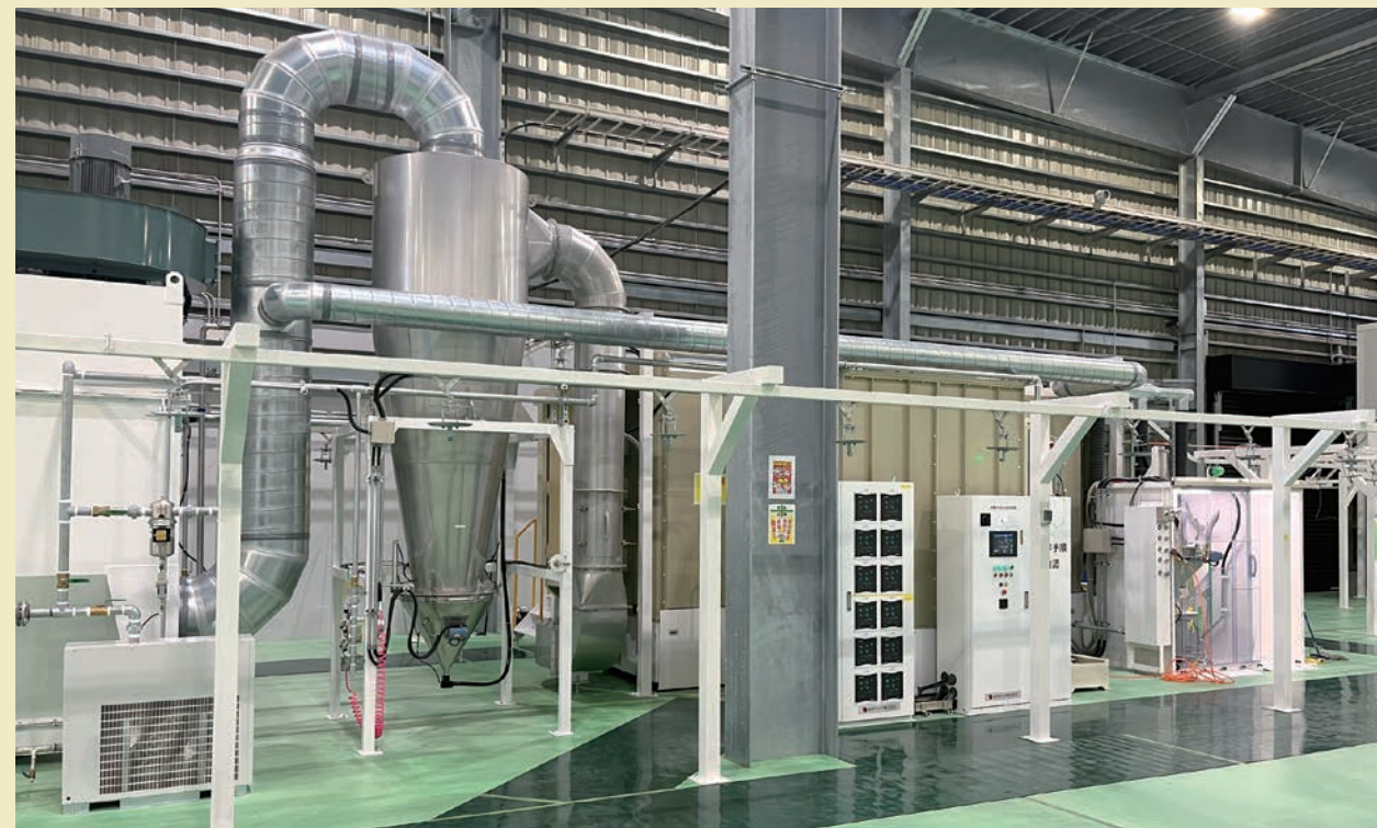
下塗り(本塗装)塗装ブースの全容
