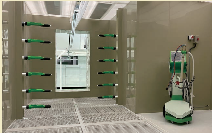
上塗り(クリヤー塗装)塗装も下塗りと同じシステム
