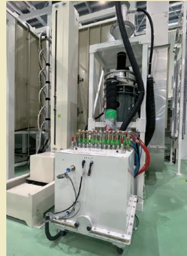
上塗り塗装の塗料供給装置
