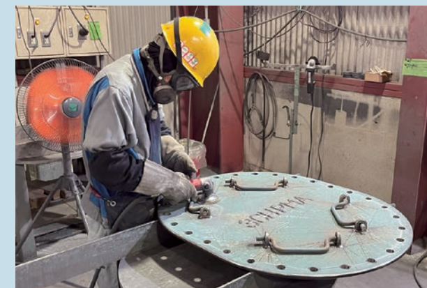
塗装前には溶接部を中心に研磨する
