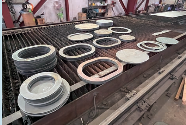
切断加工されたマンホールの座(コーミング)とカバー(蓋)
