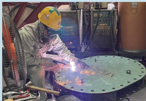
カバー(蓋)部に取り手など必要な部材を溶接
