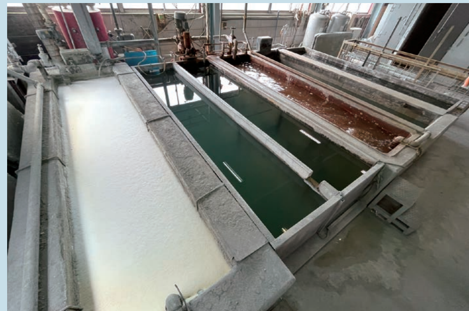
ジルコニウム化成皮膜処理を行う 前処理装置
