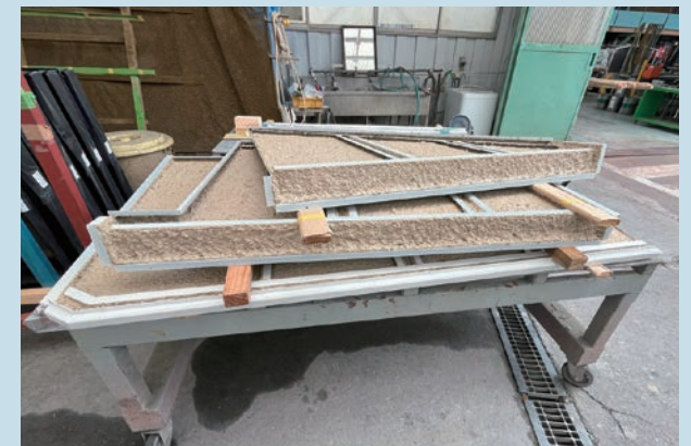
一部カーテンウォール裏打ち材を吹き付ける
