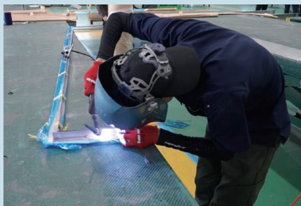
アルゴン溶接
