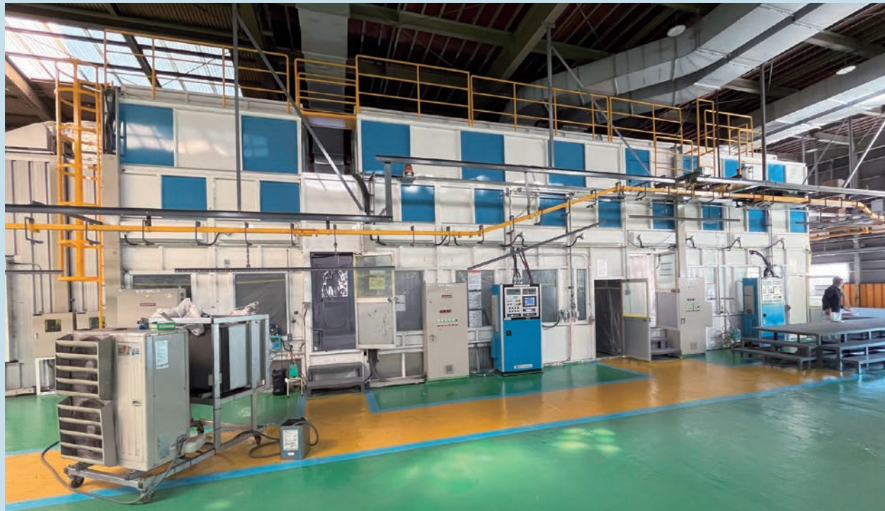
塗装ブース外回り
