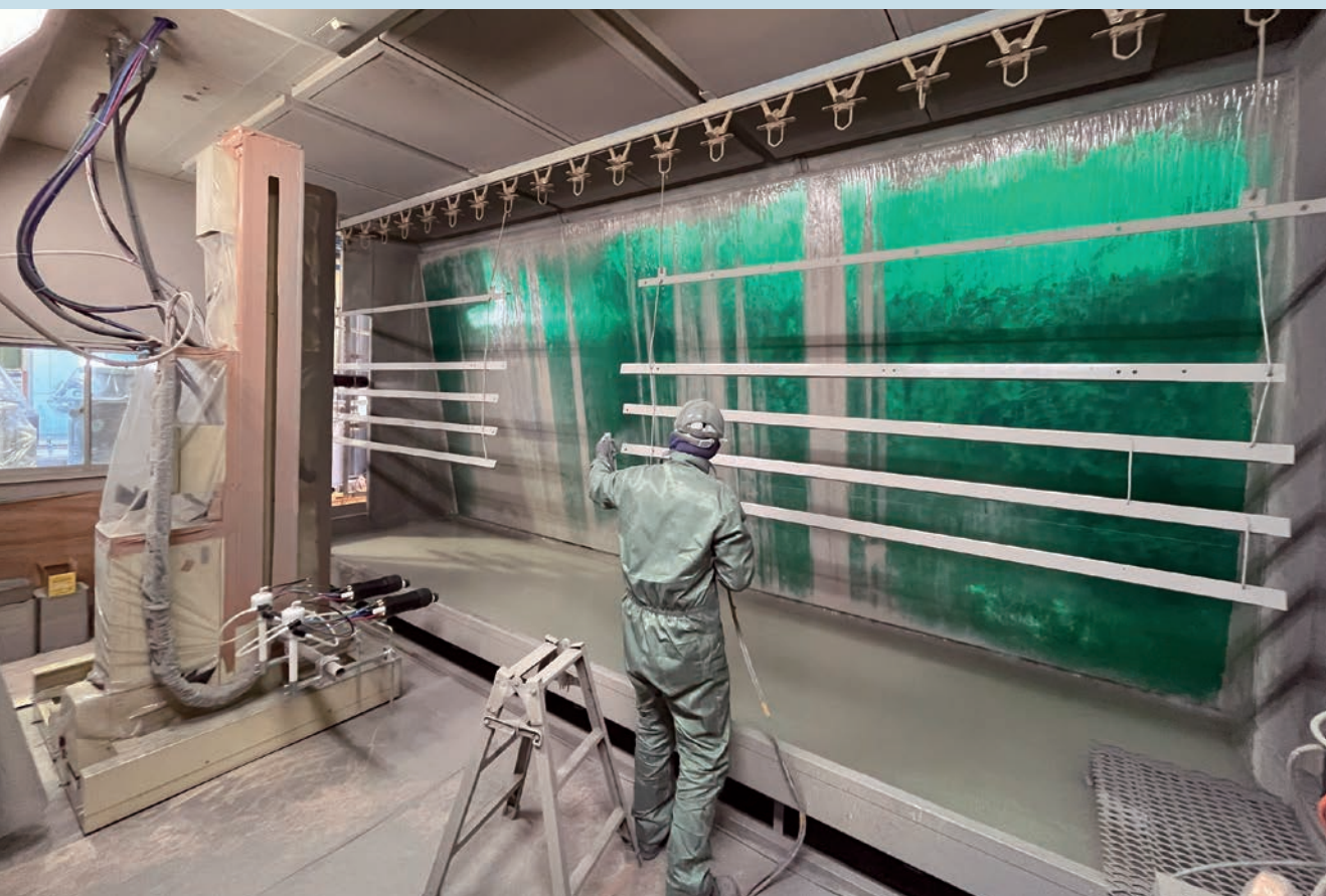
水洗塗装ブース内 (自動塗装システム+補正塗装)
