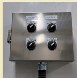
補正・手吹き塗装ブース内の手元操作盤にて、自動ガンのON/OFF設定を行うことができる
