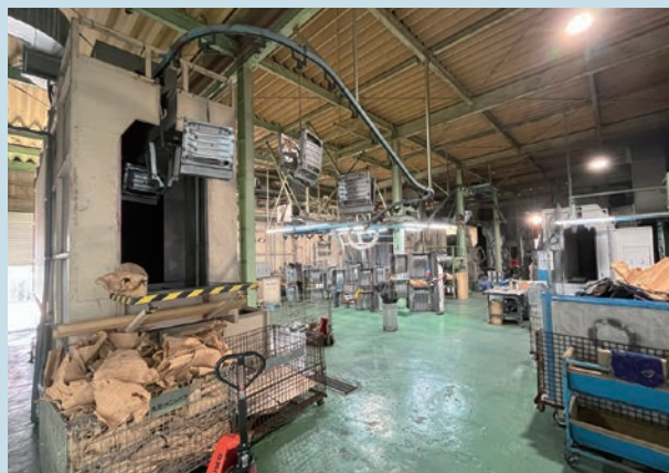
第1工場 小物専用の前処理・溶剤塗装一貫ライン
