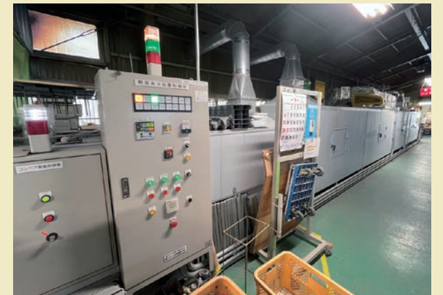
第3塗装班 網塗り塗装専用のスラット式連続乾燥炉
