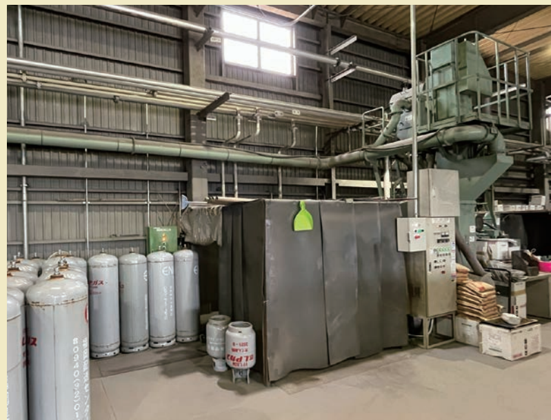
ショットブラストにより容器外面の旧塗膜を剥離する
