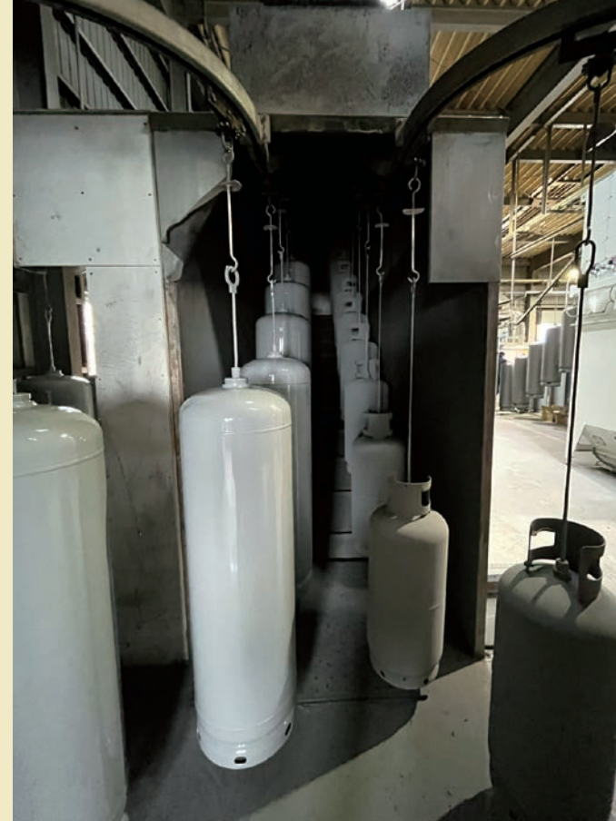
焼き付け乾燥炉出入口
