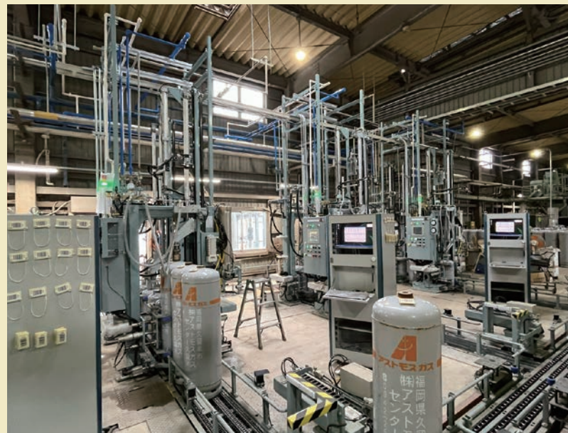
耐圧検査 所定の圧力を容器内に加え、漏れや膨張異常がないか確認(3台)
