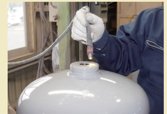
塗装後、内部に耐圧検査の水が残っていないか確認
