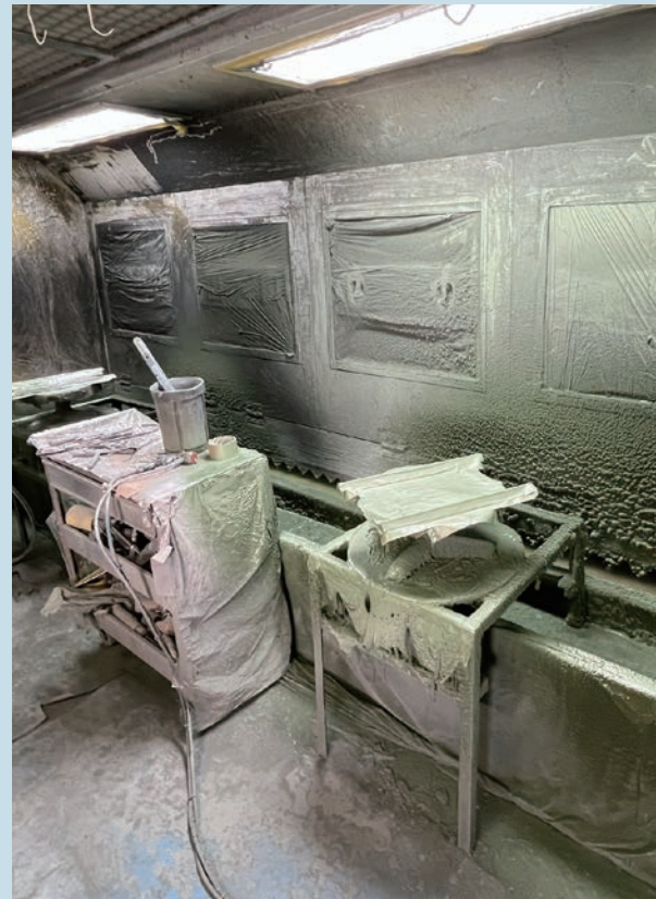
スプレー塗装ブース
